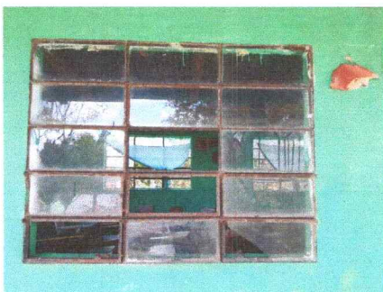
Foto 5: Se observa el mal estado de los vidrios de las ventanas y se sustituiran por nuevas.
